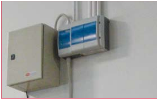
VESDA探测器与现有安全控制器直接相连，符合保险业务员的要求
