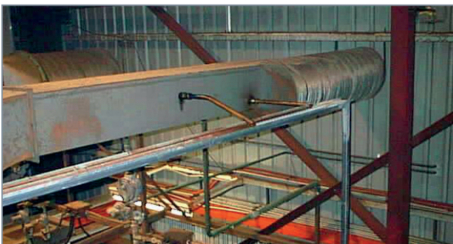
图1 - 烘炉排气采样
