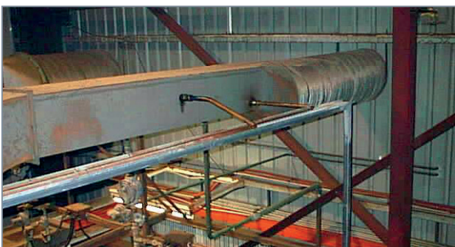
图1 - 烘炉排气采样
