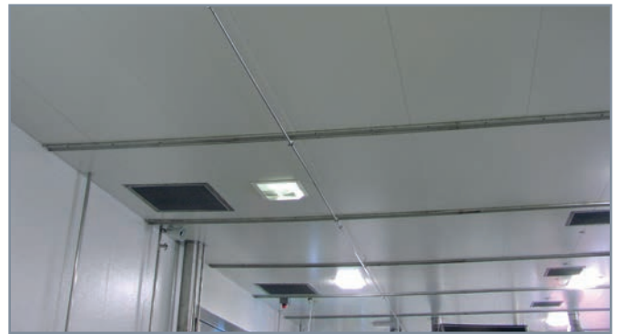
图5 - 禽类加工设施中的不锈钢采样管
