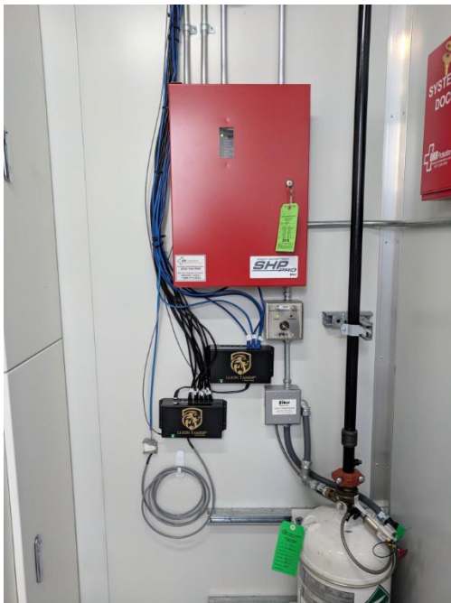
图9：安装在消防控制面板下面的控制器
