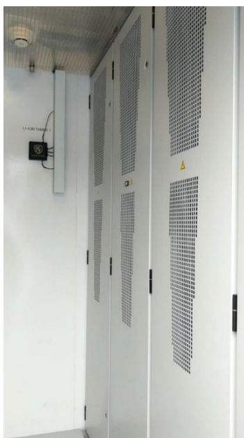
图 6：Li-ion Tamer 传感器布置
