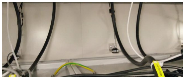
图2：监测传感器布置在电池架上方 - 安装在墙壁上
