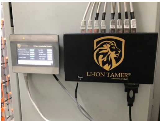
图 11：控制器连接到监测显示屏
