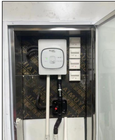
图2: FAST FLEX 和 VESDA Sensepoint XCL 安装
