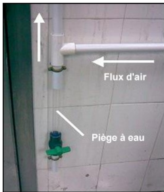
Figure 2 : Disposition du piège à eau
