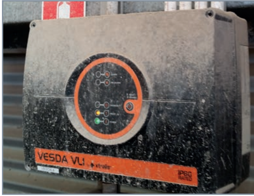
Figure 1 : Détecteur VESDA VLI dans un environnement sale sans protection
