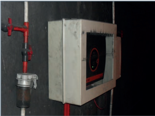
Figure 2 : VESDA VLI dans un boîtier de protection
