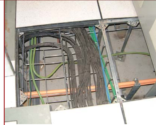
Instalación bajo el suelo
