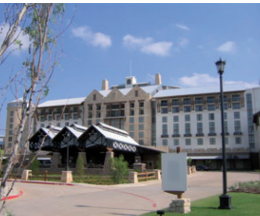
Hotel y centro de convenciones tejano Gaylord de Grapevine Lake, Dallas, Texas
