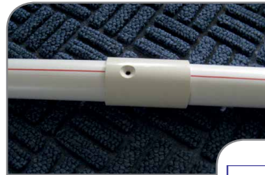
Figura 6 - Orificio perforado en la unión de tubos
