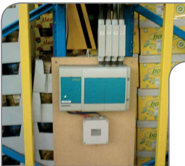
Figura 5 - VLP en un almacén con prefiltros VSP-850
