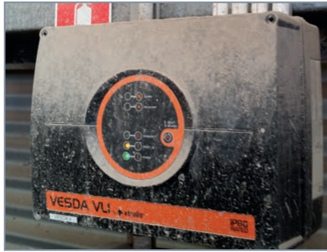
Figura 1: Detectores sin protección en ambientes sucios
