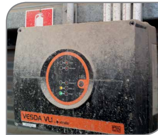
Figura 1 - Detectores sin protección en ambientes sucios
