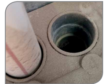
Figura 1 - Detectores sin protección en ambientes sucios
