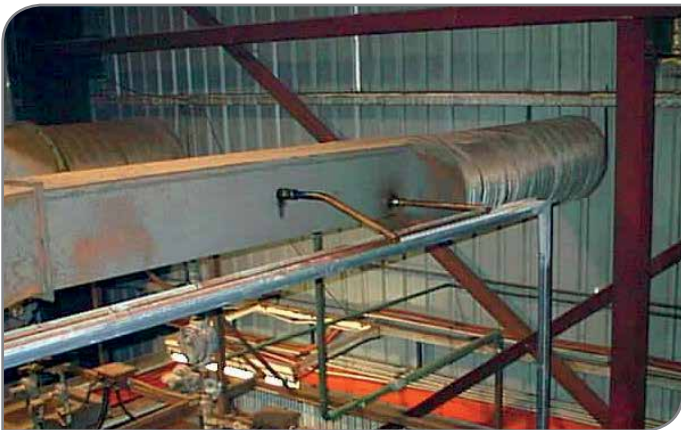
Figura 1 - Muestreo del escape de un horno asador
