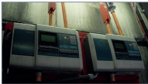
Figura 4 - Detectores montados en una excavadora
