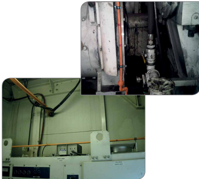
Figura 5 - Tubo de muestreo en una excavadora
