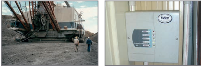
Figura 2 - Draga de cable con detector VESDA instalado
