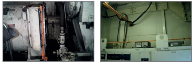
Figura 5 - Tubo de muestreo en una excavadora
