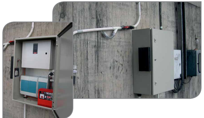
Figura 6 - Dispositivo de refrigeración termoeléctrica proporcionando refrigeración a un gabinete para el detector VESDA montado externamente.
