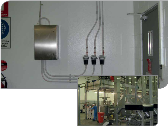
Figura 4 - Sistema VESDA en un complejo de producción de alimentos
