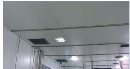
Figura 5 - Tubo de muestreo de acero inoxidable en un complejo de aves de corral
