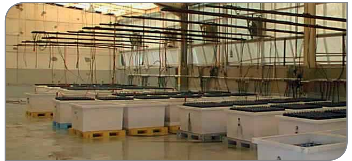
Figura 2 - Sala de carga / llenado de baterías
