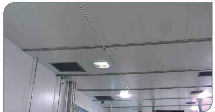
Figura 5 - Tubo de muestreo de acero inoxidable en un complejo de aves de corral
