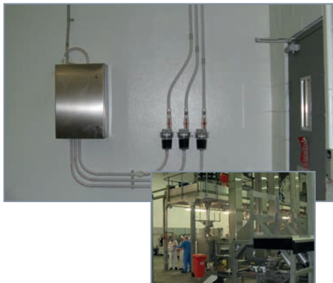
Figura 4 - Sistema VESDA en un complejo de producción de alimentos
