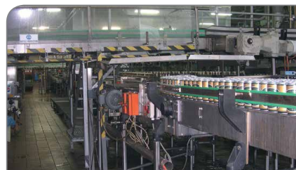
Figura 3 - Área mojada en una transportadora de una cervecería
